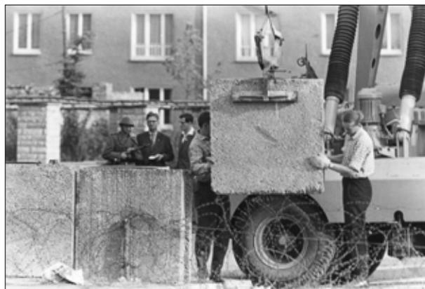
Bild 5: Bau der Berliner Mauer, Aufstellen von Betonblöcken mit einem Kran, 1961.
